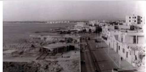
مبنى نقابة المعلمين - تم الهدم
