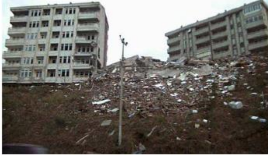
الشكل 13. انهيار مبنى بسبب ظاهرة تضخيم الاهتزازات بحكم الموقع الطبوغرافي
