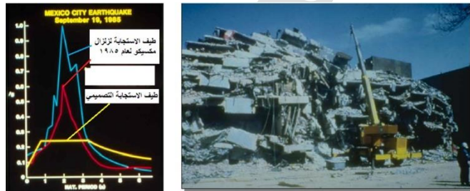
الشكل 5. انهيار مشفى بمدينة مكسيكو نتيجة ظاهرة الطنين
