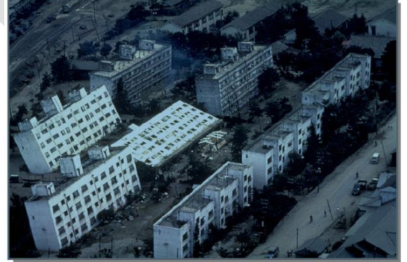
الشكل 11. الأضرار الناجمة عن تمييع تربة التأسيس (زلزال نيكاتا، اليابان 1964)
