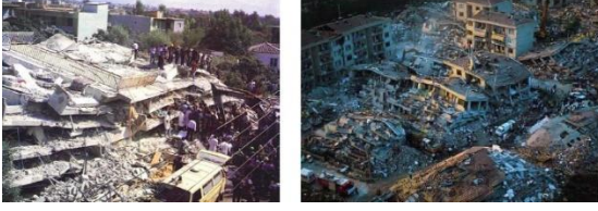
الشكل 12. انهيارات المباني بسبب ظاهرة الطنين بين المنشأة والتربة
