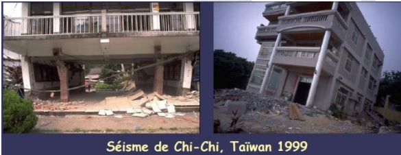
الشكل 15. انهيارات بسبب القرب من الفوالق الزلزالية
